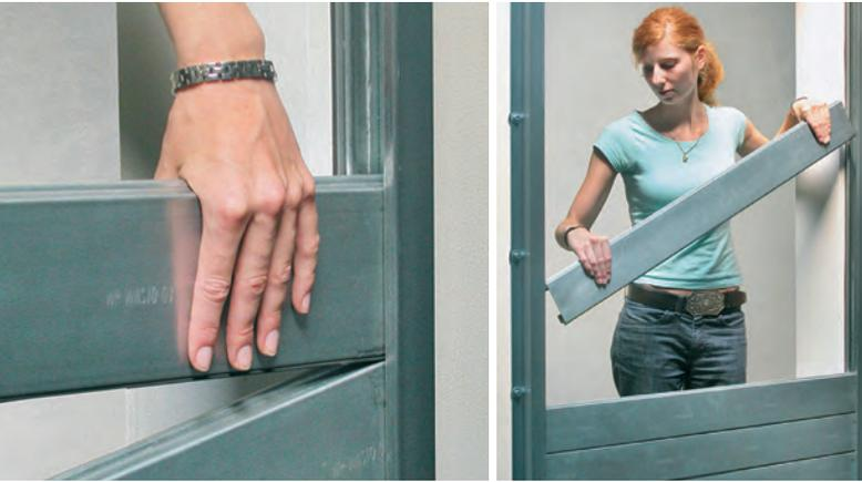
Die mit einer Dichtung beklebte, vorgelochte Seitenschiene wird links und rechts neben der Öffnung oder in der Türleibung an das Gebäude gedübelt und im Fußbereich mit abgedichtet. Im Anschluss daran werden die Lamellen in der Länge angepasst und mit vorbereiteten Dichtungen beklebt.
