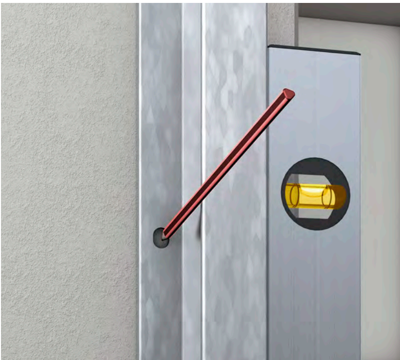
Einfache Verwendung der Zahnschiene als Bohrschablone
